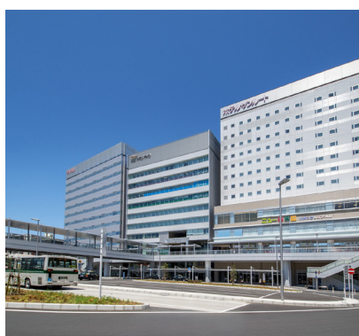
千葉駅西口地区第二種市街地再開発事業A工区 (2013年完了)
